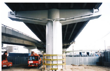
1995年 震災直前に完成した橋脚補強箇所に被害は無かった
