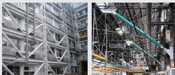
補強工事の様子
