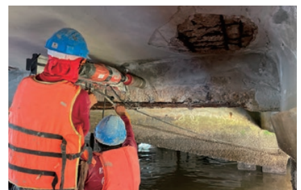
タイでの港湾補修現場
