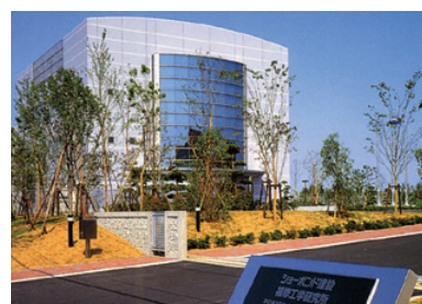
1996年 竣工した補修工学研究所
