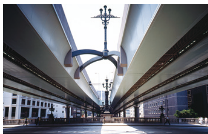
1991年 日本橋高架橋外装工事
