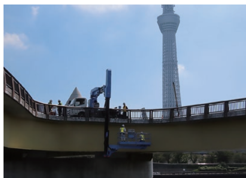
現地調査の様子
