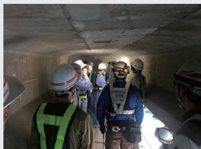
「橋梁ドクター」による視察の様子
