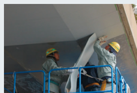
2006年 RACシート工法
