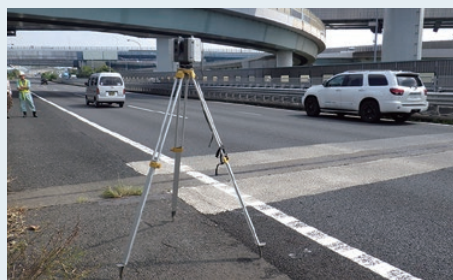
3Dスキャナーを用いた構造物計測の様子
