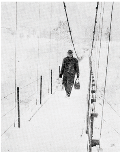
1961年 吹雪の中、ダム現場に製品を運ぶ 創業者 上田昭
