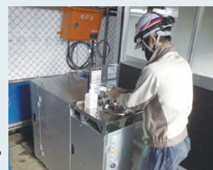
現場に設置されている 循環式手洗いユニット
