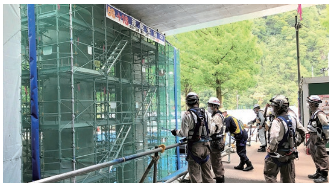
社長による安全衛生パトロール
