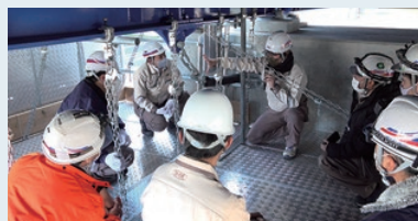
落橋防止装置の施工実習(研修用橋梁)
