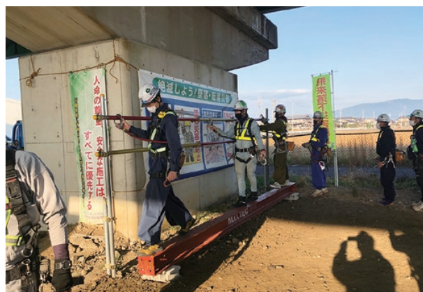
現場での安全訓練状況
