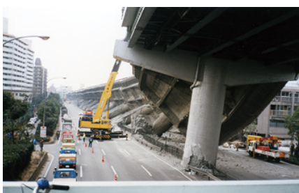
1995年 震災で倒壊した阪神高速道路
