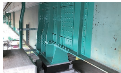
施工完了後の現場
