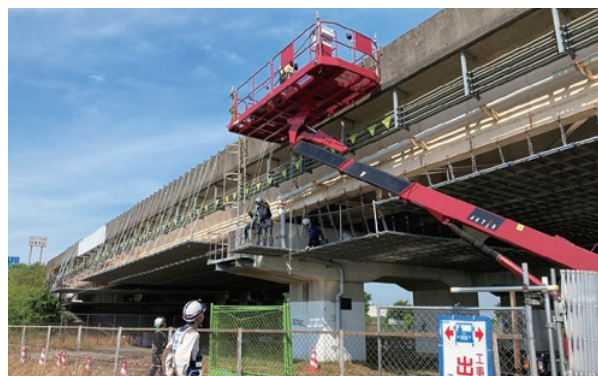
支店長による安全衛生パトロール
