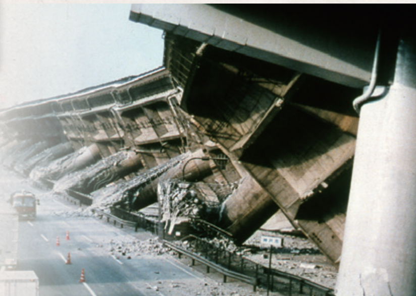
倒壊した高速道路橋（阪神高速道路3号神戸線）
