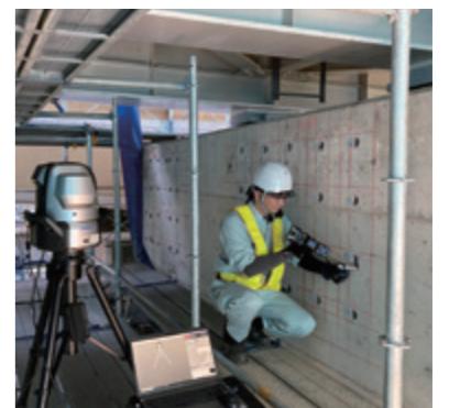
3D計測機を用いたアンカーボルト削孔位置の計測状況
