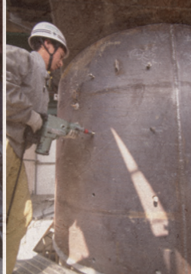
鋼板巻立法による橋脚補強
