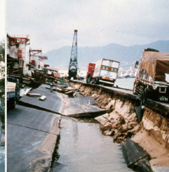
埋立地の護岸付近で生じた大きな陥没
