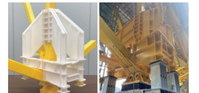
3Dプリンターで作成した模型と施工完了後の実物
