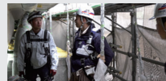
大阪支店長によるブラインドパトロールの様子
