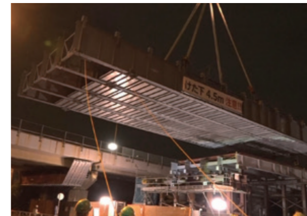
2018年 高速道路リニューアル工事の様子
