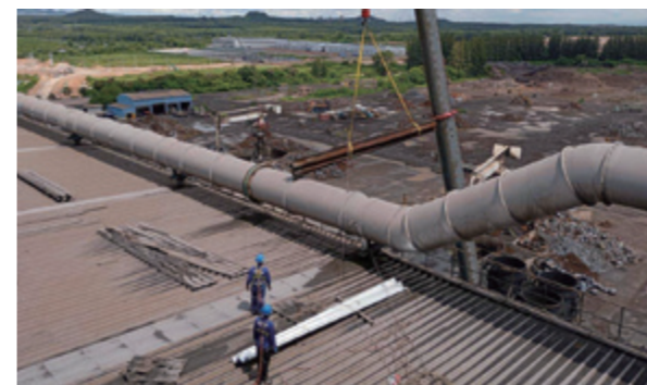
↑日系工場の屋根の補修を行いました。
