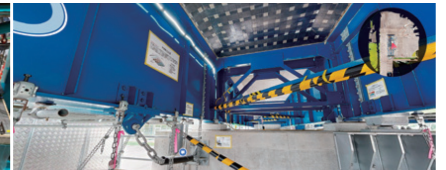
つくば研修センター橋梁のMatterportによる3D空間の撮影
