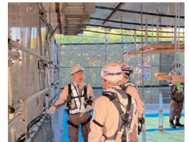
社長による安全衛生パトロール
