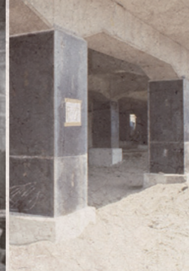
鋼板接着により補強された新幹線高架橋の橋脚
