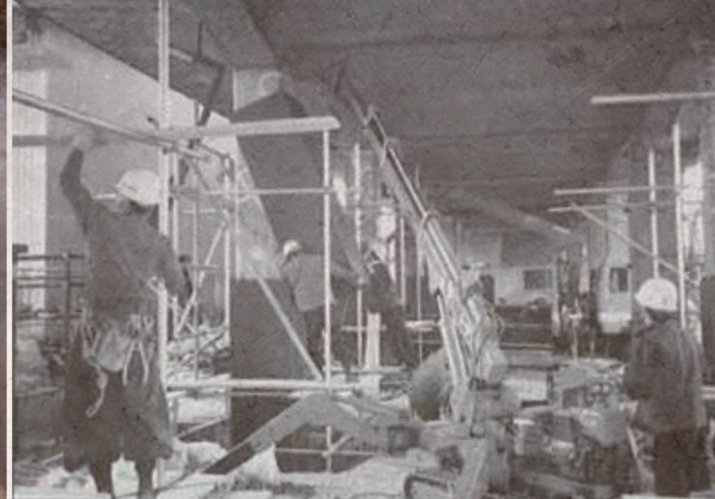
新幹線復旧工事の現場
