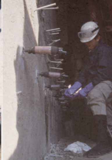
樹脂注入による橋脚のひび割れ補修
