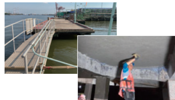
↑日系化学プラント施設の港湾栈橋を補修しました。
