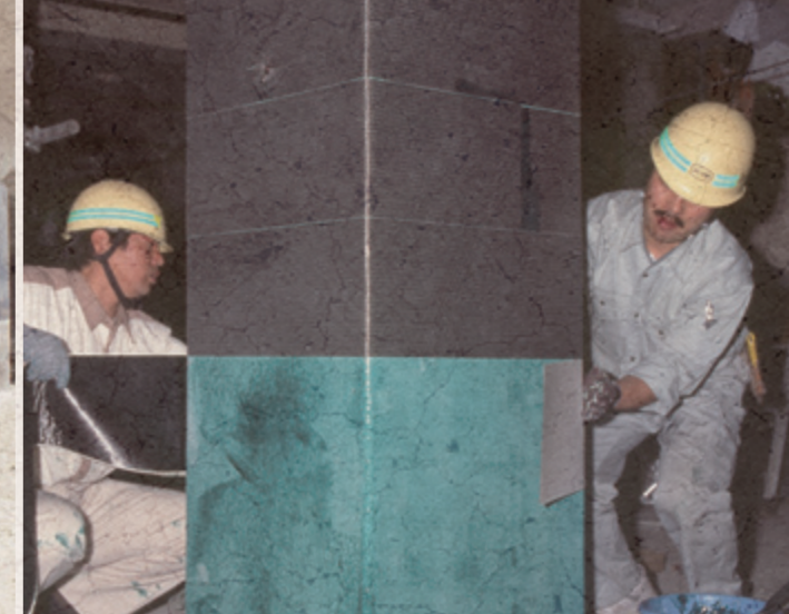
CFRPを用いた柱の補強
