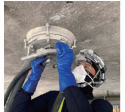
WJを用いたコンクリートの表面処理
