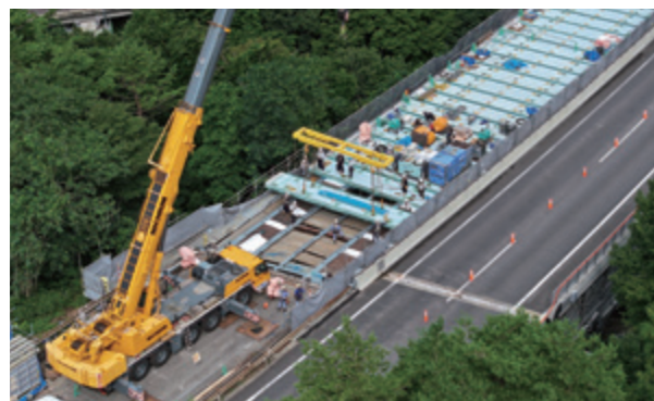
天狗橋での床版取替施工
