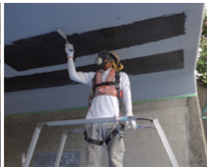
1液水性ウレタン樹脂を用いたはく落対策
