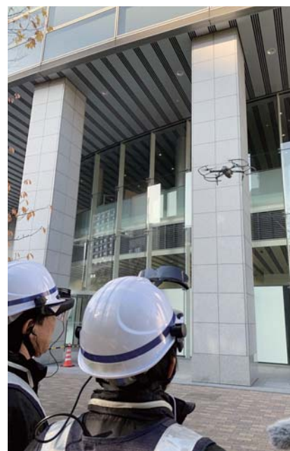
ドローンとARスマートグラスを活用したビル外壁点検
