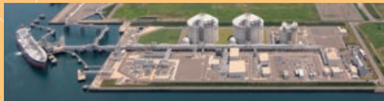
直江津LNG基地
