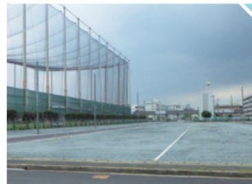
▲ セキスイハイム山陽(株) 城東68区画 宅地造成工事
