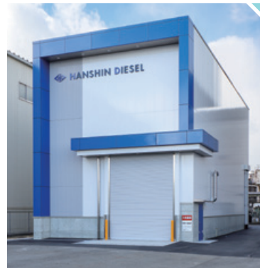
▲ 阪神内燃機工業(株) 播磨工場高度研究棟 建設工事
