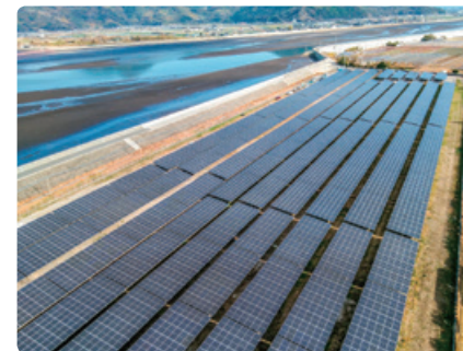
▲ サンテックパワージャパン熊本太陽光発電所 建設工事
