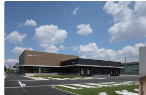
▲ 川西市中学校給食センター 整備・運営PFI事業
