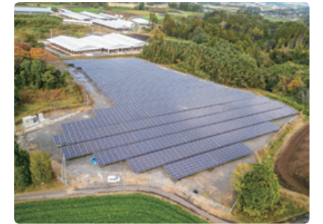
▲ 桜花ソーラーガーデン太陽光発電所 設置工事
