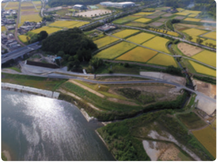
▲ 河高地区 市道付替他工事
