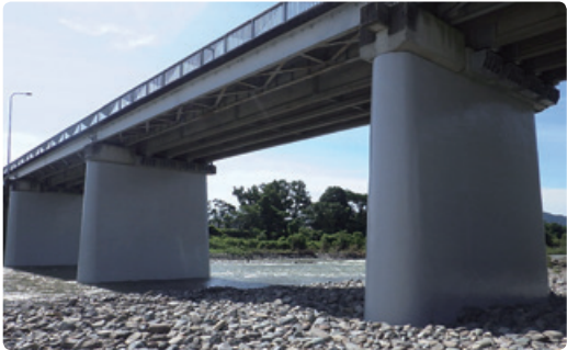
▲ 中寺北条線中津橋 補修・耐震補強工事（その2）
