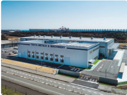
▲ 蔦機械金属(株) 広畑工場 I 期工事
