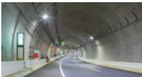
横浜環状北西線シールドトンネル (神奈川県) 2019年 大断面、長距離、大深度のトンネルを確実に施工するために、「スマートシールド®」システム等の先進技術を積極導入
