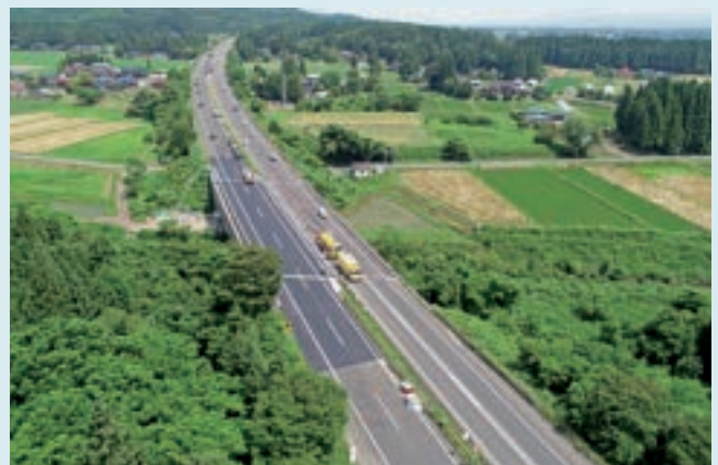
東北自動車道 滝名川橋床版取替工事
