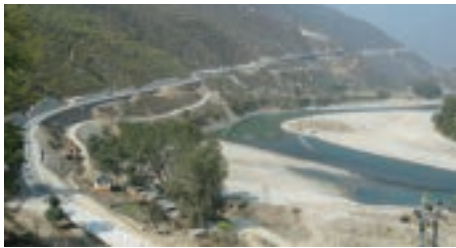
シンズリ道路 (ネパール) 2015年 1996年より日本政府の無償資金協力事業として始まり、総延長160kmの道路を19年間にわたり施工 2015年度土木学会技術賞、2020年第3回JAPANコンストラクション国際賞
