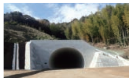
六条院トンネル
