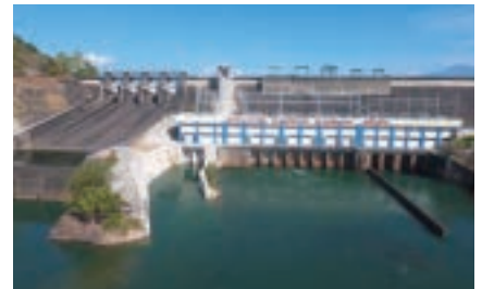
ナムグム第一水力発電所
