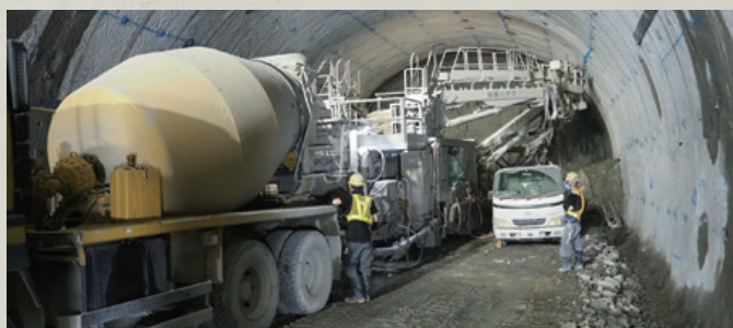
ミキサー車と吹付け作業
