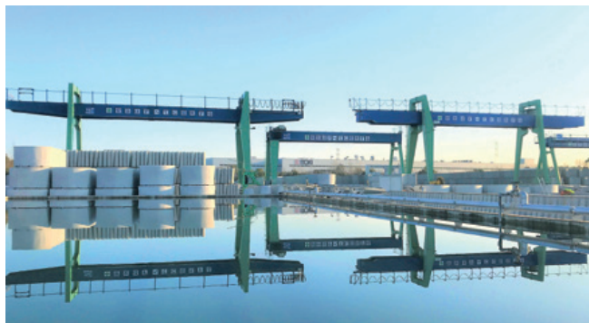
千葉工場 PCa製品の養生用水槽とストックヤード
