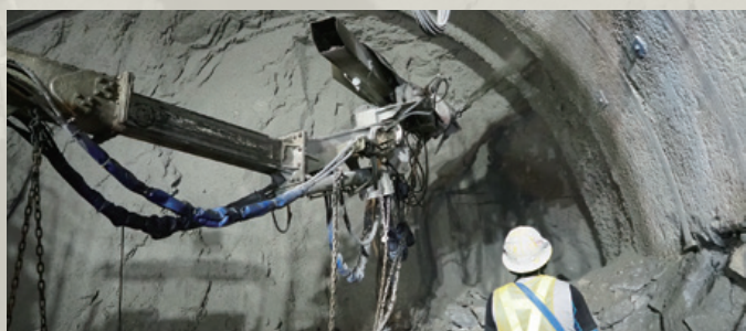
吹付けコンクリート施工状況
