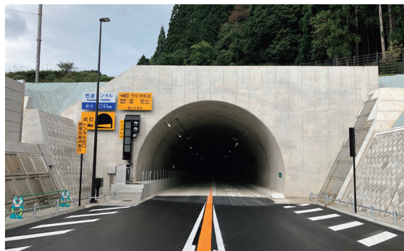
笠波峠除雪拡幅笠波トンネル工事 発注者：国土交通省近畿地方整備局
