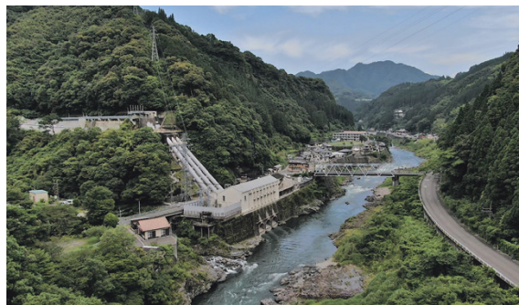
五ヶ瀬川発電所土木設備撤去工事一式及び土木設備改修工事一式 発注者：旭化成株式会社
