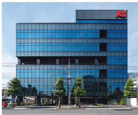
ケーズホールディングス本社新築工事 発注者：株式会社ケーズホールディングス
