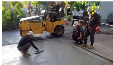
試験施工状況
