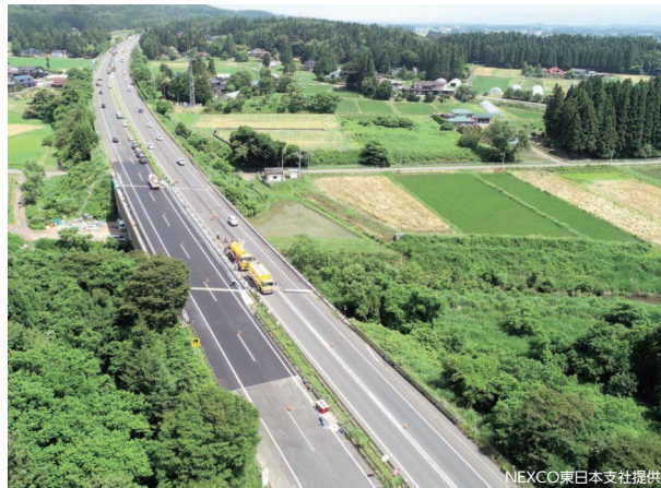
工事名：東北自動車道 滝名川橋床版取替工事 発注者：東日本高速道路株式会社
