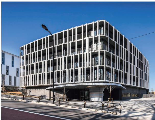
工事名：東洋大学赤羽台国際学生寮（仮称）新築工事 発注者：学校法人東洋大学
