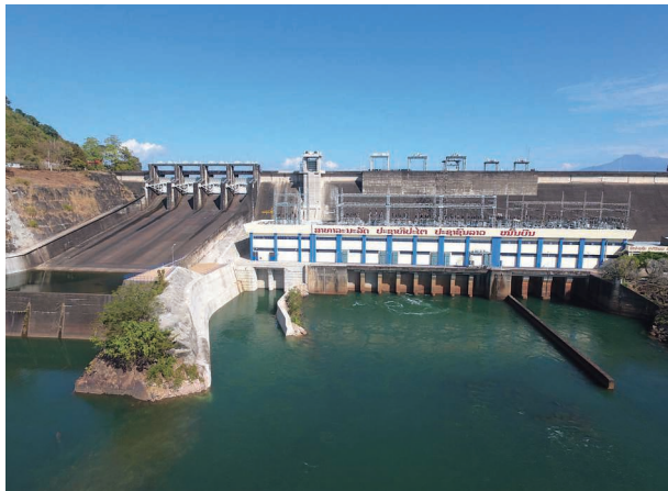
工事名：ナムグム第一水力発電所拡張計画 LOT.1 発注者：ラオス電力公社
