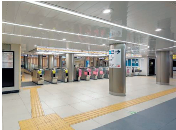
工事名：外苑前駅出入口2改良その他に伴う建築・土木工事 発注者：東京地下鉄株式会社
