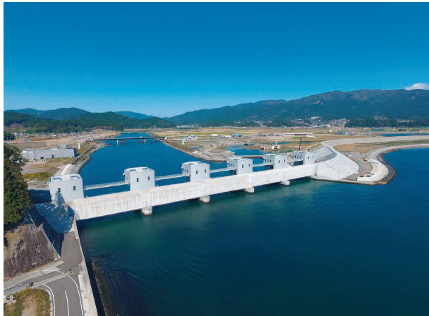
工事名：二級河川気仙川筋砂盛地区河川災害復旧（23災589号） 水門土木工事 発注者：岩手県
