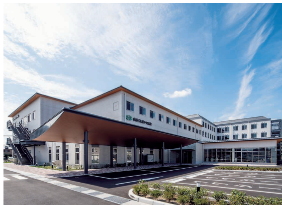
京都民医連中央病院建設工事 発注者：公益社団法人京都保健会
