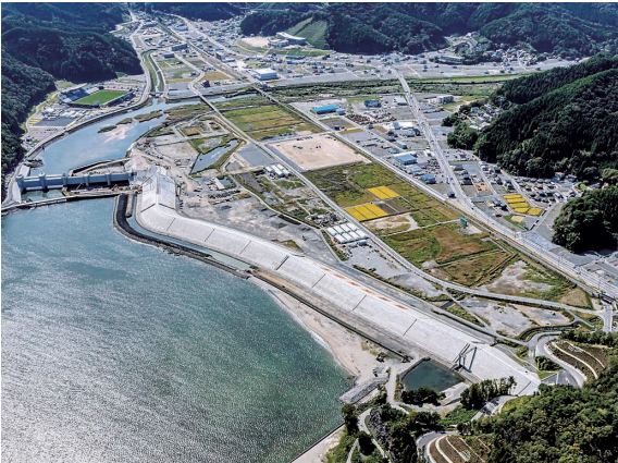
片岸地先海岸災害復旧（23災570号）工事 発注者：岩手県
