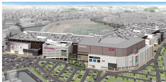
（仮称）イオンモール川口新築工事 発注者：サイバー株式会社
