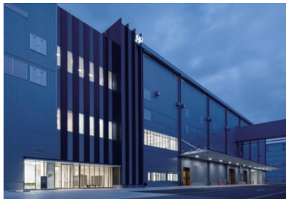
（仮称）関東エコペット工場建設工事 発注者：株式会社エフピコ
