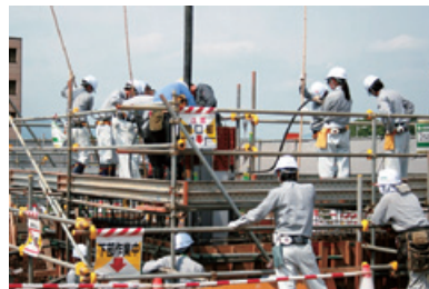
模擬現場での施工実習風景
