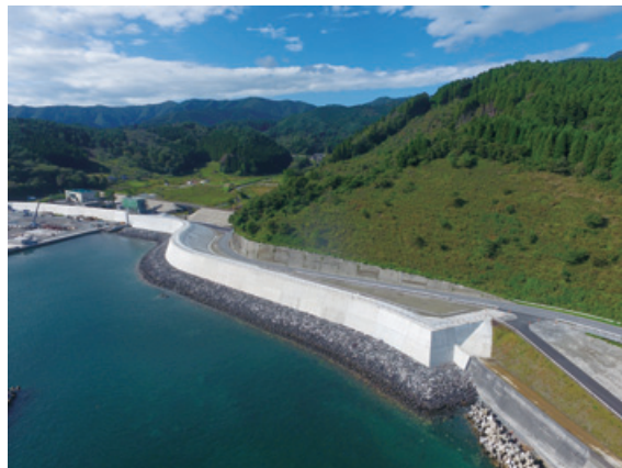
越喜来地区海岸災害復旧（23災519号及び606号）工事 発注者：岩手県
