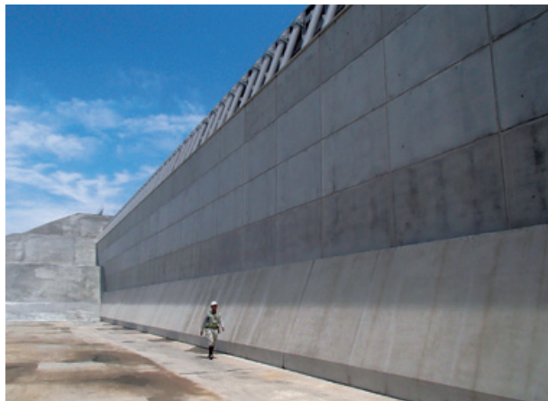
工事名：浜岡原子力発電所 防波壁設置工事の内上部工工事（東工区） 発注者：中部電力株式会社
