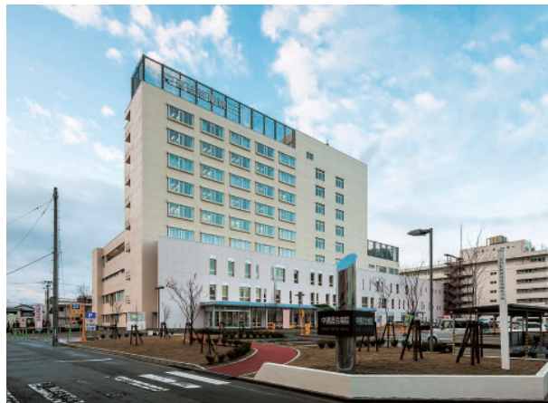
工事名：中通総合病院新築及び改修工事（秋田県） 発注者：社会医療法人明和会
