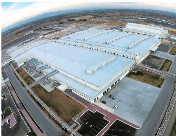
工事名：4EM-TM project (HDM新トランスミッション工場新築工事) (メキシコ) 発注者：Honda de Mexico, S.A. de C.V.
