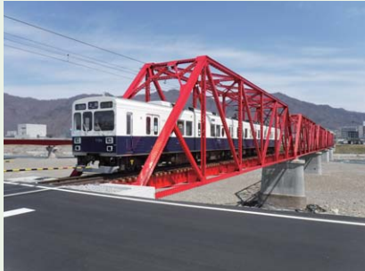
上田電鉄別所線千曲川橋梁災害復旧
