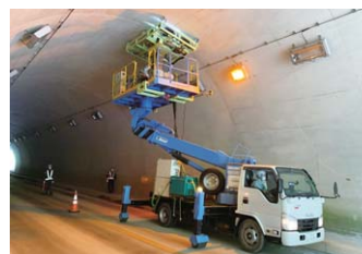
iTOREL（トンネルの点検作業風景）
