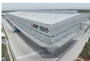
三菱電機コンシューマープロダクツ新工場
