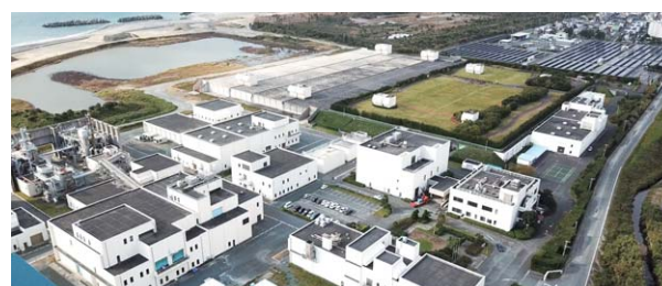
浜松市公共下水道終末処理場(西遠処理区)運営事業
