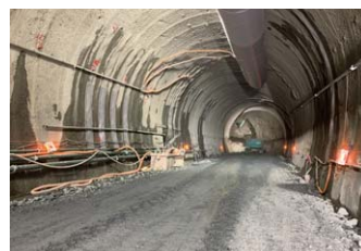
防じん測定状況（全景）
