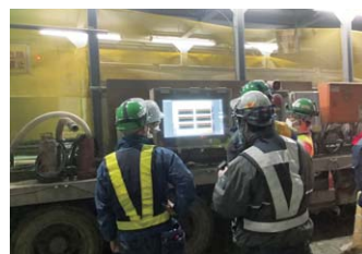
大型タッチパネルPCを用いた管理状況
