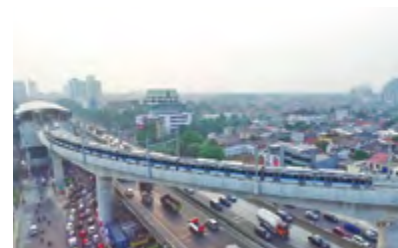
ジャカルタ大量高速輸送システム 建設工事 (インドネシア)
