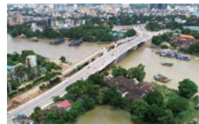
ヤンゴン市新タケタ橋 建設工事 (ミャンマー)
