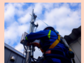
Outdoor RUアンテナGPS取り付けの様子
