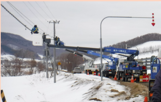
光ファイバケーブルの敷設工事
