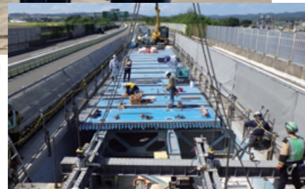
既設床版の取替施工状況
