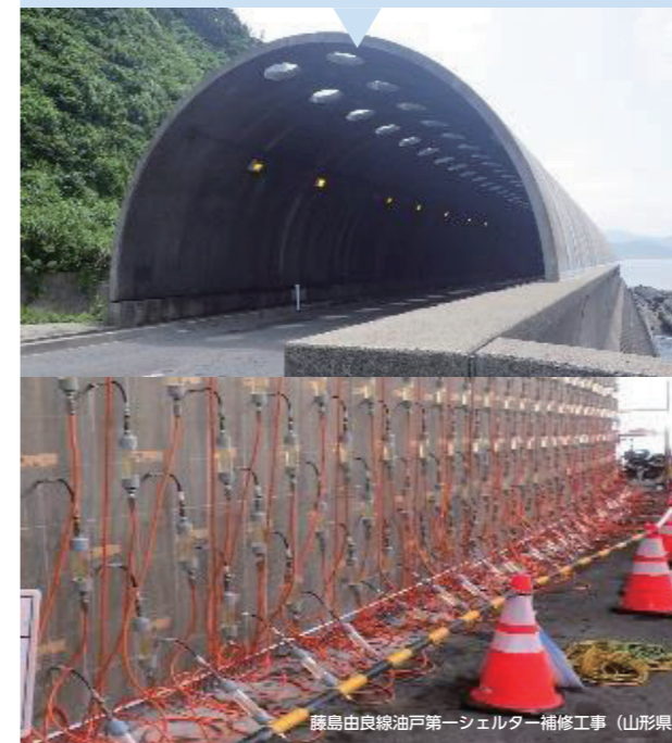
藤島由良線油戸第一シェルター補修工事 (山形県)
