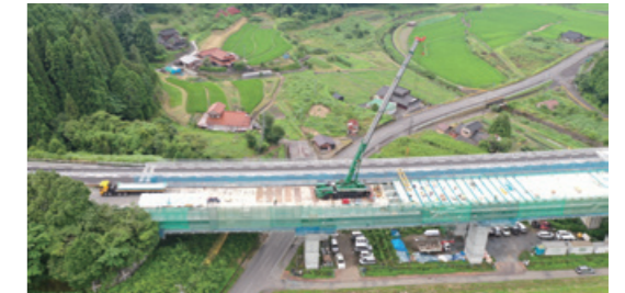
高速道路床版取替工事例：赤山橋（山口県）
