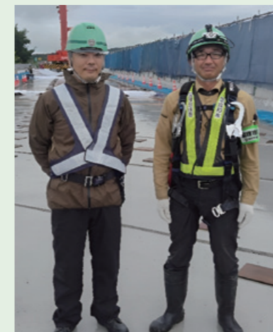
広戸川橋の床版更新現場にて 開発担当：三本 技術企画部長（写真左側） 現場担当：福本 監理技術者（写真右側）
