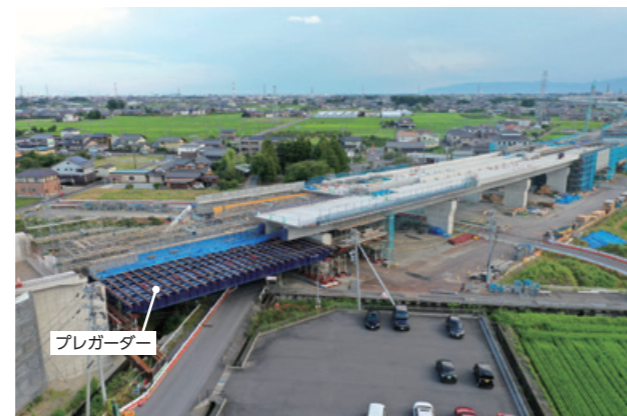
新設橋梁の施工状況
