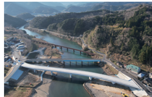
新設橋梁工事例：矢田橋（兵庫県）
