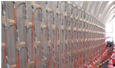
主要地方道藤島由良線油戸第一シェルター補修工事
