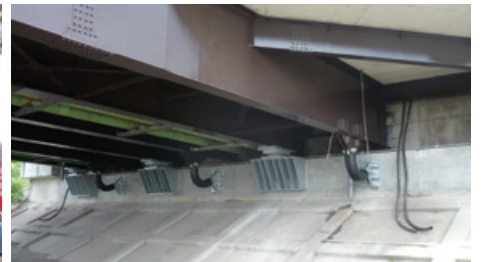
高砂橋橋梁耐震補強及び補修工事(その2)
