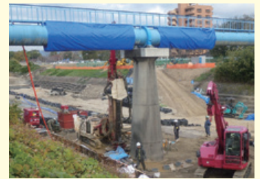
STマイクロパイル工法の様子
