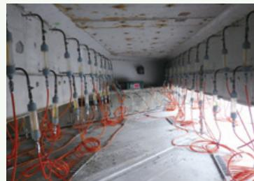
今回の工事は、橋梁全体をリニューアルするというこれまで行われた補修工事の中でも最大規模のもので、鉄筋コンクリート桁の塩害及び中性化対策に有効な当社のK-LIP工法が採用されました。
