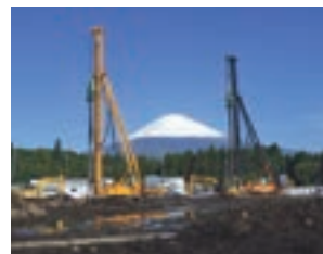
地盤改良工事施工風景
