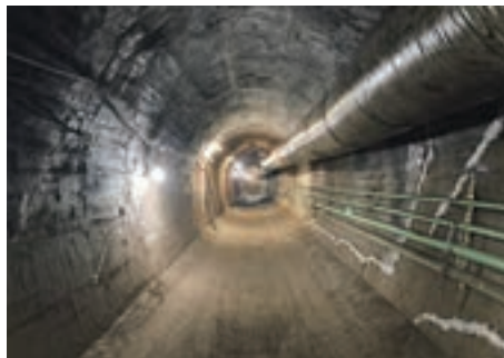
長距離水路トンネル閉塞工事
