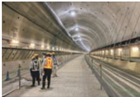
現場打設後写真
