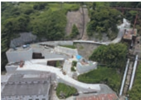
道路拡幅盛土工事
