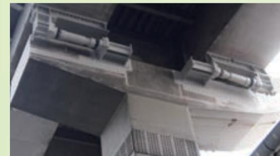
摩擦ダンパーを設置した橋梁(11号台場線)
