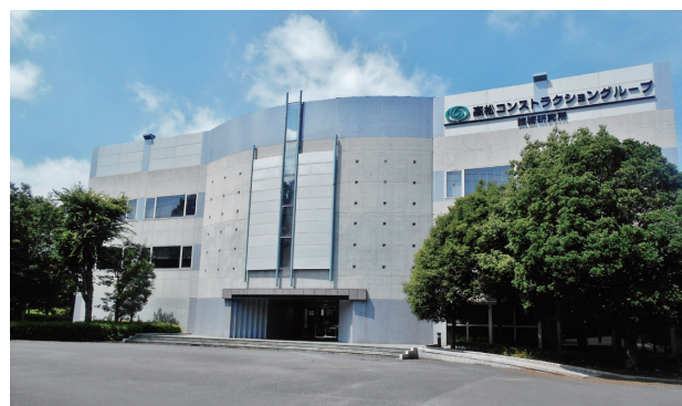
写真-1 技術研究所(正面玄関)
