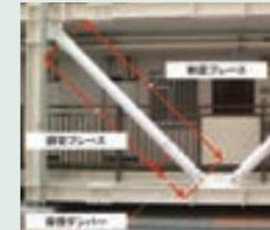
写真-4 制震ブレースの構造
