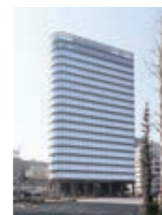
東京都港区芝に完成した高松コンストラクショングループ東京本社ビル
