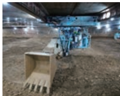
呑龍ポンプ場
