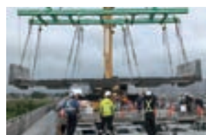
北陸自動車富山立山間床版取替工事
