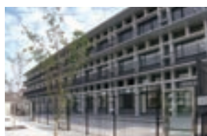
岩国市立岩国東小中学校建設工事
