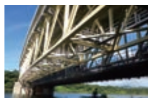
億首川橋(上り線)他2橋床版取替
