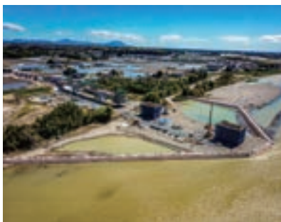
LRT鬼怒川橋梁
