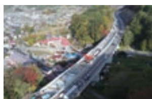
中央自動車道辰野TN～伊北IC間改良工事
