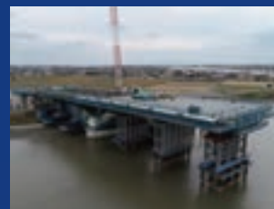
早津江川橋上部工事
