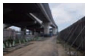
第601工区(香椎浜)高架橋
