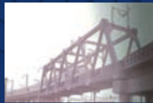
日本初のPCTラス橋、岩鼻架道橋
