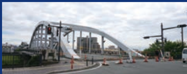
白川橋応急復旧工事
