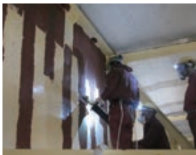
IH式塗膜剥離機を用いた工事
