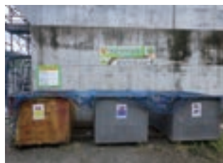
工事現場における産業廃棄物の保管 産業廃棄物の処理及び清掃に関する法律に基づき産業廃棄物の保管を行っています。
