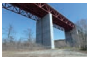
メップ川橋応急復旧工事
