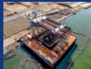
鎮守大橋ケーソン
