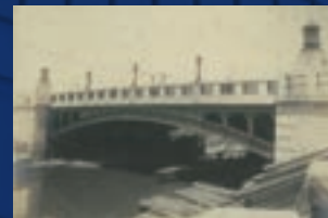
岩井橋完成時(名古屋市)
