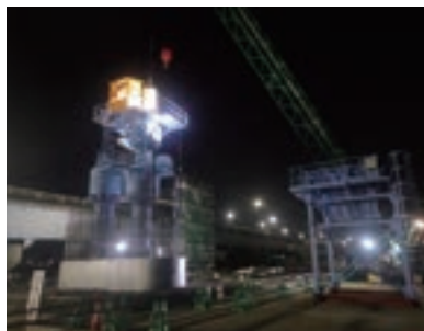
掘削状況(夜間)
