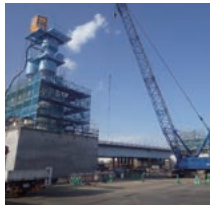
施工状況(昼間)
