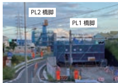
スリムケーソン施工状況
