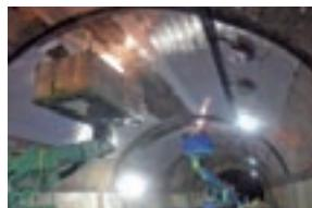
はく落防止シート施工(辰野トンネル)
