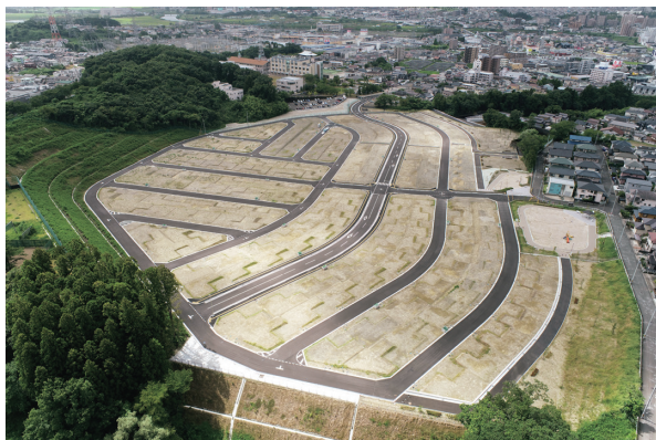
泉区本田町宅地造成工事
