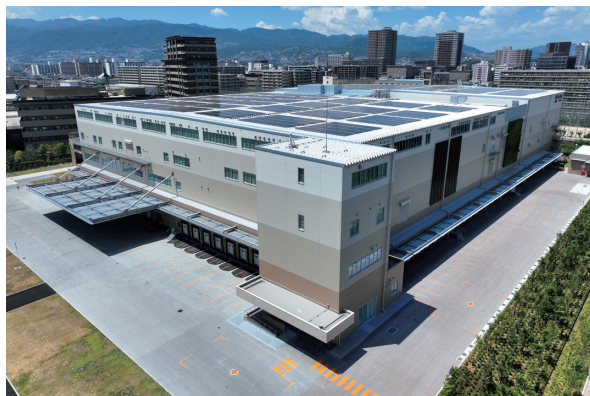
株式会社メディセオ 阪神ALC新築工事
