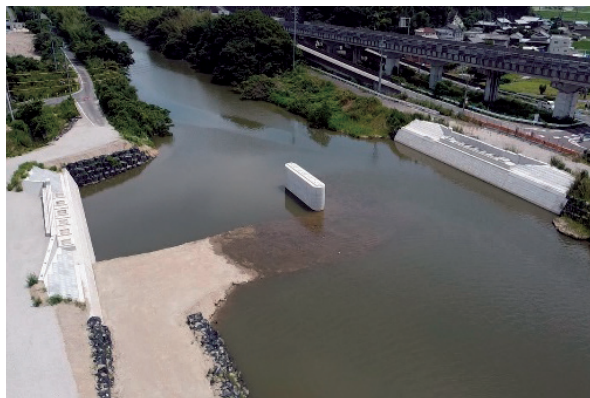
公共 河川激特工事(芳野橋下部工)
