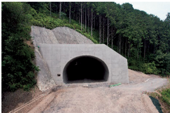
令和3—4年度 牟岐BP大谷第1トンネル工事
