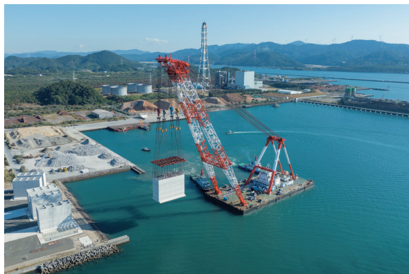
令和5年度川内港(唐浜地区)岸壁(-12m)ケーソン製作外1件工事
