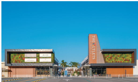
THE OUTLETS HIROSHIMA 増床工事 イオンモール(株) (広島県)
