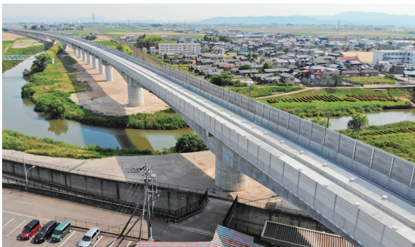
北陸新幹線 竹田川橋りょう他建設工事 ㈱鉄道建設・運輸施設整備支援機構
