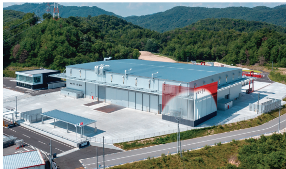
広島テクノパーク統括工場新築工事 (株)アクティオ (広島県)
