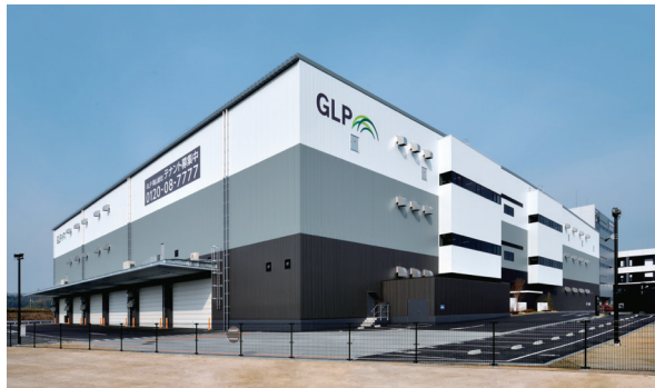
GLP岡山総社IIIプロジェクト 総社3ロジスティック特定目的会社 (岡山県)
