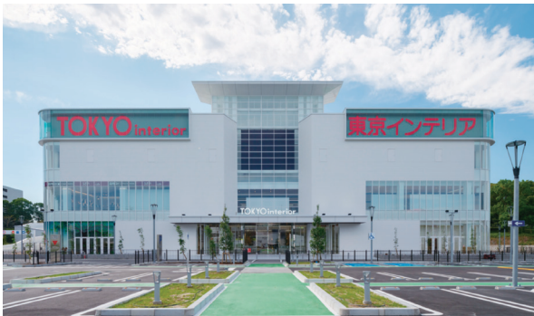
長久手店新築工事 (株)東京インテリア家具 (愛知県)
