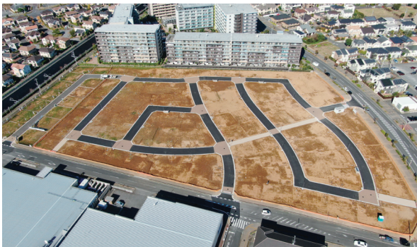
みらい平203街区宅地造成工事 茨城セキスイハイム㈱他11社
