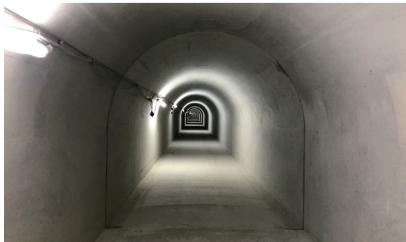
三方原用水（二期）農業水利事業 導水幹線水路5号バイパストンネル建設工事 農林水産省
