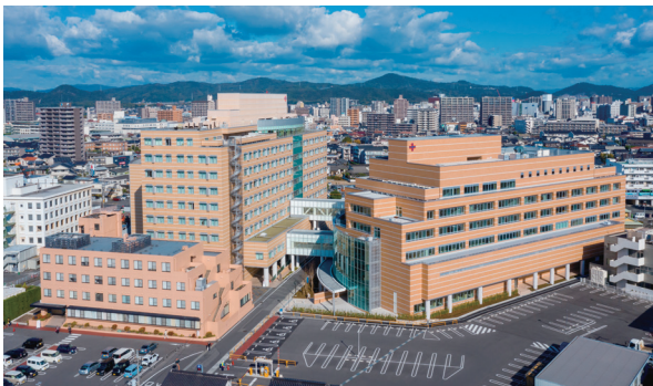
新棟建築工事及びクリニック既存棟改修工事 (一財)倉敷成人病センター (岡山県)
