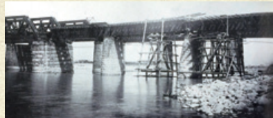
信越線川中島長野間犀川橋梁工事 (昭和21年8月竣工)
