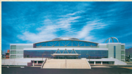
オリンピック冬季競技アイスホッケーA会場建設工事 (ビッグハット)(平成7年3月竣工)
