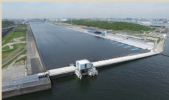
平成27年度海の森水上競技場整備工事 (東京都江東区) 発注者: 東京都
