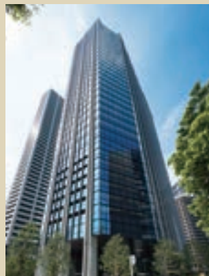
住友不動産 新宿セントラルパークタワー (東京都新宿区) 発注者: 住友不動産株式会社
