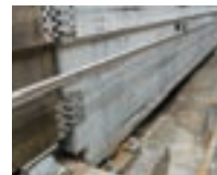
東京モノレール軌道桁
