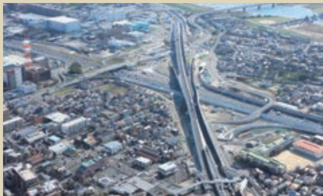
東京外環自動車道 田尻工事 (千葉県市川市) 発注者: 東日本高速道路株式会社
