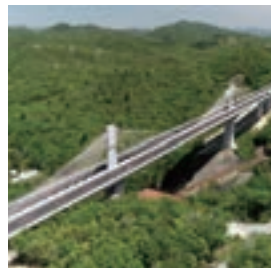
新名神高速道路 生野大橋 (PC上部工)工事(兵庫県神戸市)
