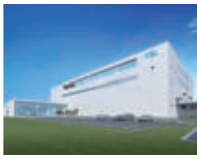
東京エレクトロン テクノロジーソリューションズ東北事業所 新築工事(岩手県奥州市)
