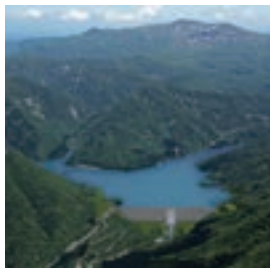
成瀬ダム原石山採取工事(第1期) (秋田県雄勝郡)
