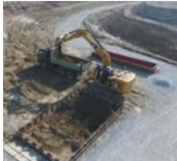
自律制御による掘削積込作業
