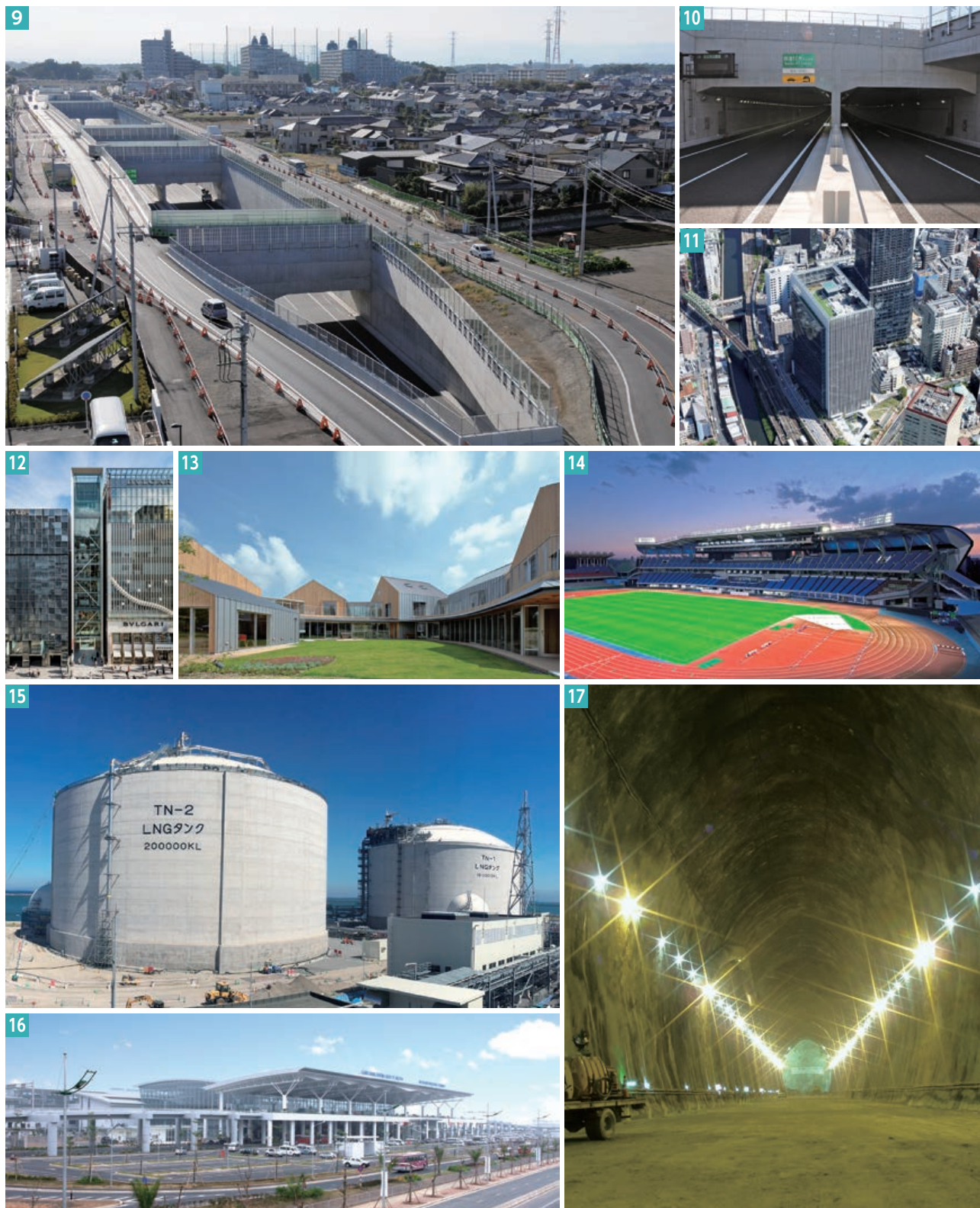
9・10 圏央道桶川北本地区函渠その1 11 御茶ノ水ソラシティ 12 G.IToya 13 TSURUMIこどもホスピス 14 等々力陸上競技場 15 プレキャスト型枠を用いたPCLNG貯槽(石狩LNGタンク) 16 ノイバイ国際空港第2旅客ターミナルビル 17 波方国家石油ガス備蓄基地
