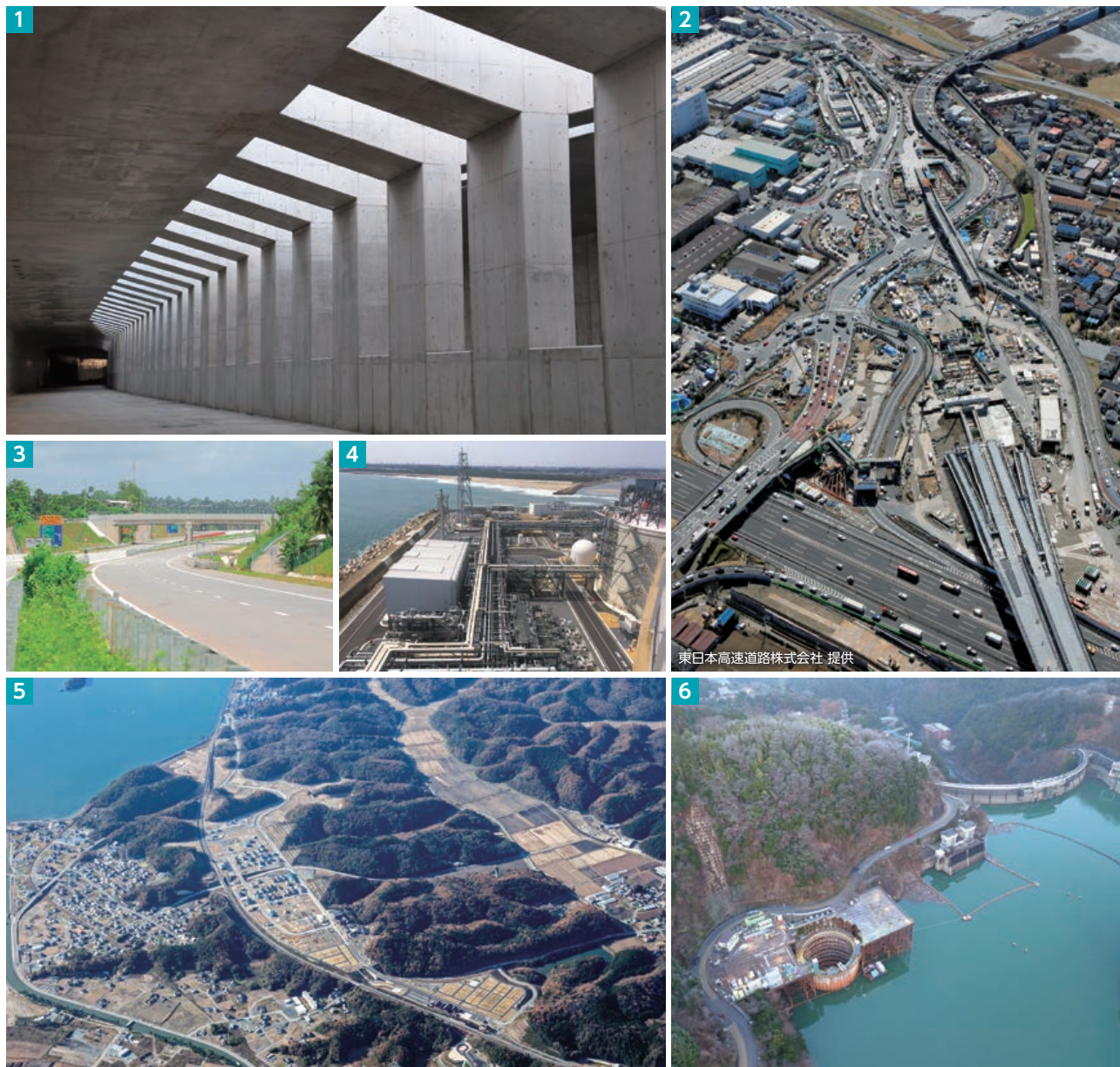
1 東京外かく環状道路 矢切函渠その10 [千葉県松戸市～市川市] 発注者:国土交通省 関東地方整備局 2 東京外環自動車道 田尻工事[千葉県市川市] 発注者:東日本高速道路(株) 関東支社 3 スリランカ・コロンボ外郭環状道路北工区-1 (OCH) 発注者:スリランカ高速道路省 道路開発公社 4 日立LNG基地 [茨城県日立市] 発注者:東京ガスエンジニアリングソリューションズ(株) 5 野蒜北部丘陵地区 震災復興事業の工事施工等に関する一体的業務[宮城県東松島市] 発注者:(独)都市再生機構 6 天ヶ瀬ダム再開発トンネル 放流設備流入部建設工事[京都府宇治市] 発注者:国土交通省 近畿地方整備局
