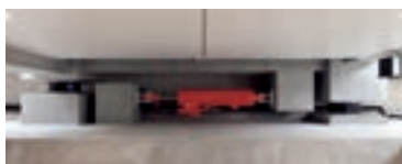
都市型小変位免震システム （切替型オイルダンパー）
