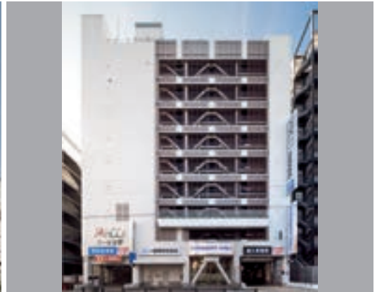
調布パルコAパーキングビル外観
