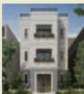
災害に強い鉄筋コンクリート住宅「パルコン」(大成建設ハウジング(株))
