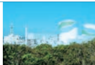
九州電力(株)川内原子力発電所1・2号機
