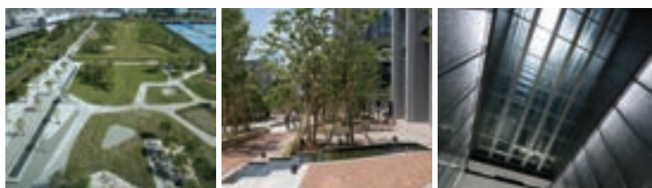
左／南東から北西への「風の道」を冷やす風の森 中央／暑さを和げる保水性ブロック舗装 右／オフィスエントランスや、共用部廊下に自然光を取り入れる「スカイボイド」
