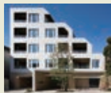
老朽化マンション建替え事業(オーベル戸越公園・東京都 大成有楽不動産(株))
