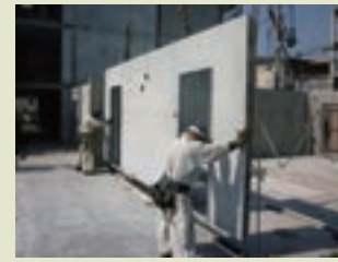
建設現場での壁式PCの組み立て (大成ユーレック(株))
