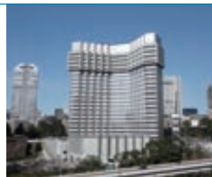
旧グランドプリンスホテル赤坂新館。 環境負荷低減を行う解体工法 テコレップシステム
