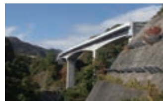
東北中央自動車道長老沢橋に適用
