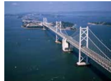
1985 南北備讃瀬戸大橋(下部工、北工区)
