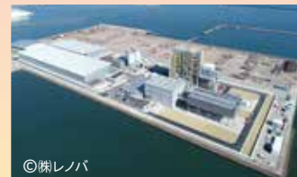
徳島津田バイオマス発電所
