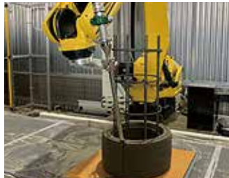
鉄筋近傍での施工状況
