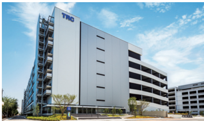
東京流通センター物流ビルB棟新築工事(東京都)
