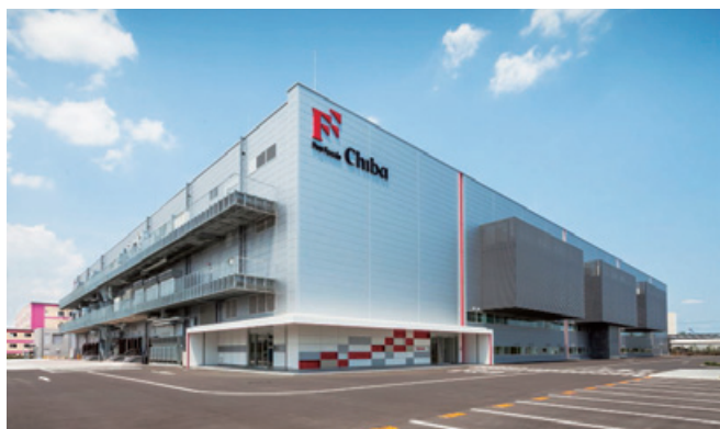
フジフーズ(株)千葉工場新築工事(千葉県)
