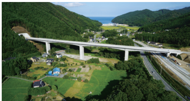
国道45号 吉浜釜石道路工事(岩手県)
