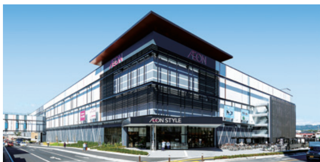
イオンモール東松本A、B棟新築工事(長野県)
