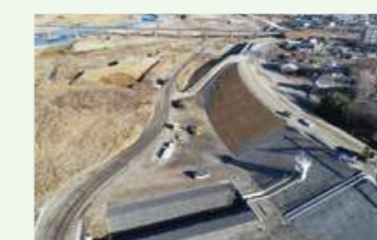
ICT機械による盛土状況
