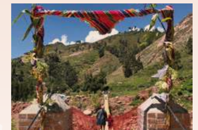
標高3,000mを超えるボリビアの山岳地帯に鋼製梁・木材デッキの橋を架設
