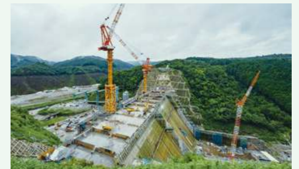
タワークレーンを用いたコンクリート自動運搬システム
