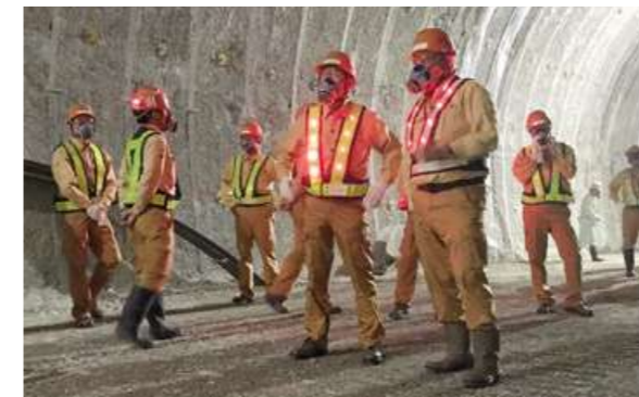
トンネル坑内での粉じん障害防止状況の確認パトロール
