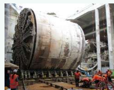
1本目のトンネル掘削を終えて立坑内で旋回し、そのまま2本目を掘進して工期を短縮
