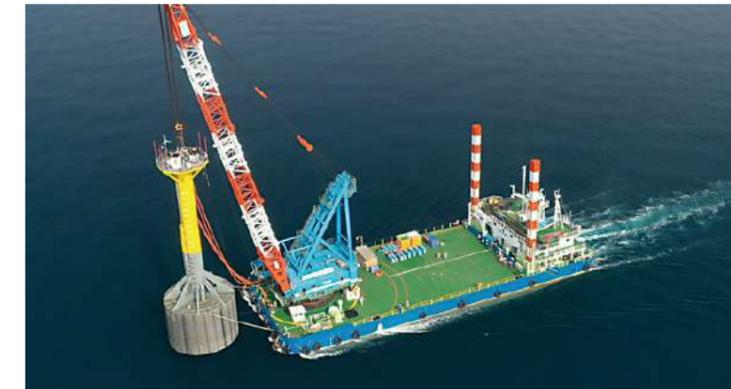
「スカートサクション®」は円筒形の鉛直壁(スカート)を海底地盤に貫入させる当社独自の技術です。スカート内外の水圧差を利用し、大型の機械を使わずに洋上風力発電所の基礎を大幅な短工期と低コストで強固に固定することを可能にします。本格化する洋上風力発電所の建設需要に対応すべく、その技術を確立しました。
