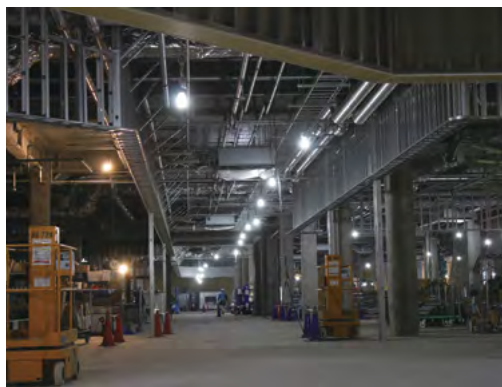
延べ面積が13万m 2 以上のショッピングセンターの建設現場に、約1,600個のLED照明を設置。消費電力は、白熱電球の約7分の1、蛍光灯の約3分の2
