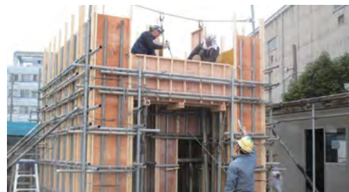
型枠の組み立てを実際の作業を通じて習得します
