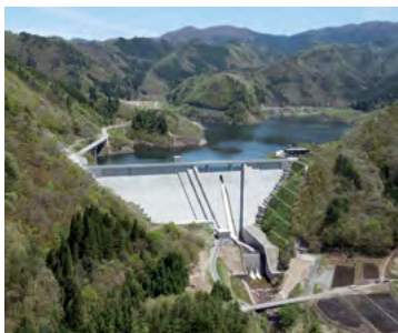
丹生川多目的ダム
