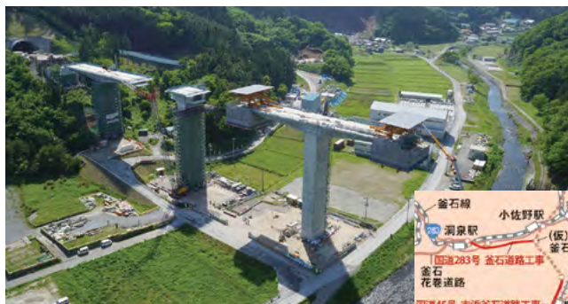
「国道45号 吉浜釜石道路工事」 (唐丹第2高架橋、荒川トンネル)
