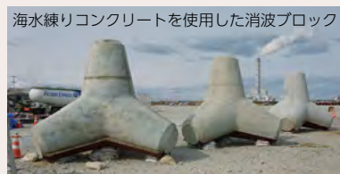
海水練りコンクリートを使用した消波ブロック
