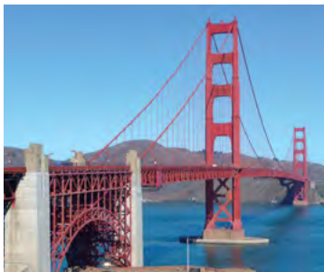
ゴールデンゲートブリッジ耐震補強(アメリカ)
