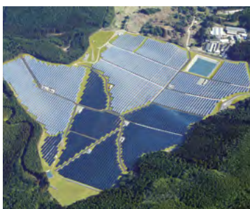
芦北太陽光発電所
