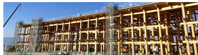
大屋根リング施工風景
