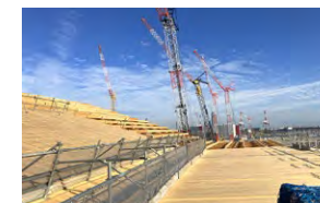
CLT床材施工風景
