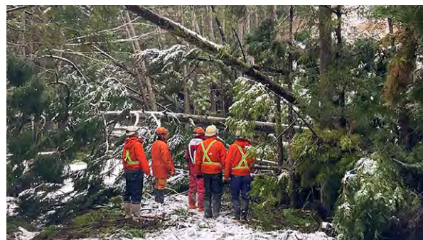
のと里山海道 三井IC付近の道路啓開作業事前調査
