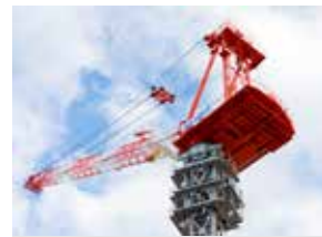
主力の大型タワークレーン
