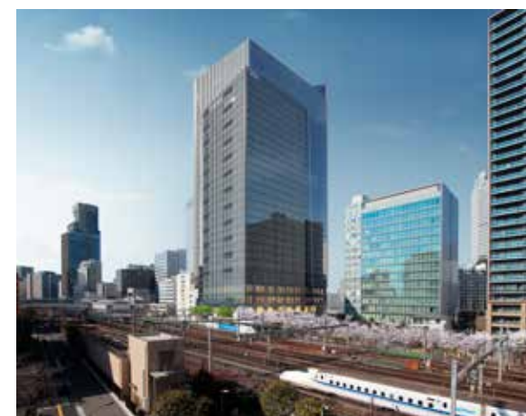
TTMプロジェクト新築工事(東京都港区)
