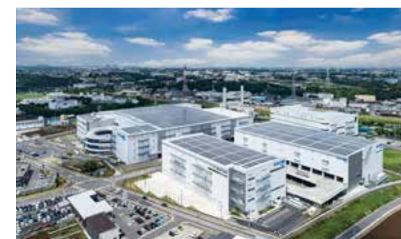
S・LOGI新座 手前がEast2(埼玉県新座市)
