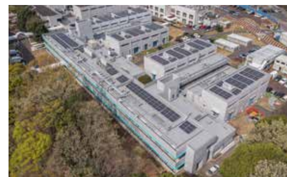
改修工事によりZEBを達成した産業技術総合研究所 研究施設(茨城県つくば市)
