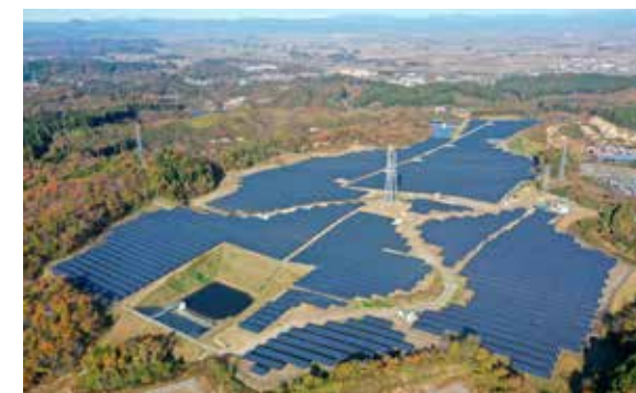
JPS20大崎市三本木太陽光発電所(宮城県大崎市) 発電容量:11.88MW
