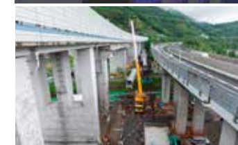
3次元データを活用した施工シミュレーション(上)と実際の施工の様子(下) 新東名高速道路川西工事(神奈川県足柄上郡)
