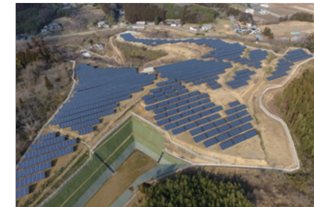
宮城登米太陽光発電所(宮城県)
