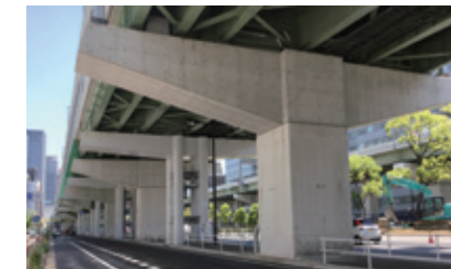
都市高速道路の拡幅技術(西船場JCT)
