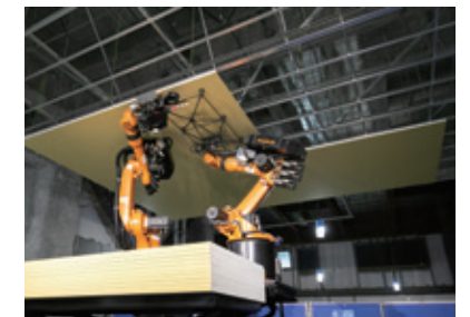
天井を施工する「ROBO-BUDDY」
