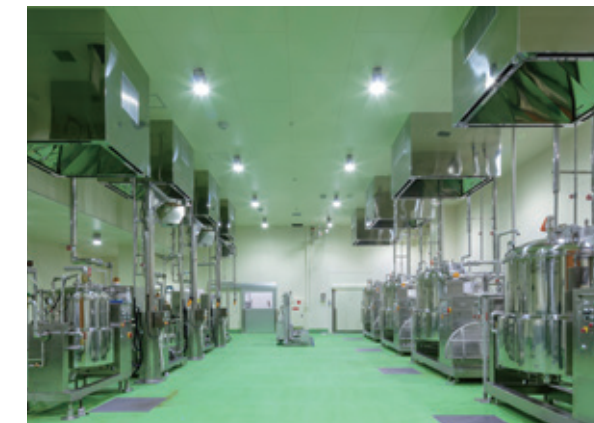
熊本地震直後の復旧支援に引き続き、最新鋭食品工場の生産設備の設計・施工を行った(株)お菓子の香梅 阿蘇西原工場(熊本県)
