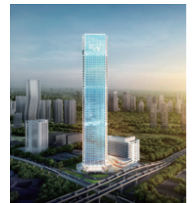
設計施工のノウハウを活かしたジャカルタ中心部での超高層オフィスビルダスウィンオフィスプロジェクト(完成予想図 インドネシア)
