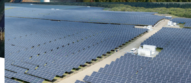
ユーラス六ヶ所ソーラーパーク 2015年、青森県上北郡六ヶ所村で日本最大級のメガソーラー「ユーラス六ヶ所ソーラーパーク」を建設。発電規模は11万5千kW/交流(一般家庭の約3万8千世帯相当分)で、年間約7万tのCO 2 削減に貢献。また、兵庫県赤穂市や岩手県北上市に建設したメガソーラーでは、発電所の運営事業を展開
