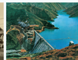
1959 黒又川第一ダム
