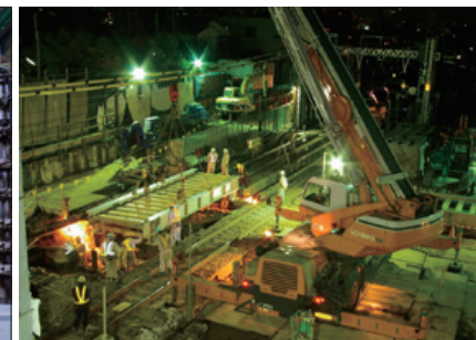
日本初の営業線直下における4線地下式での 線増連立事業 —都市高速鉄道第9号線の完遂— (小田急電鉄小田原線)
