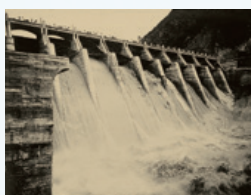
1936 矢作水力発電所 ※現在中部電力(株)が保有
