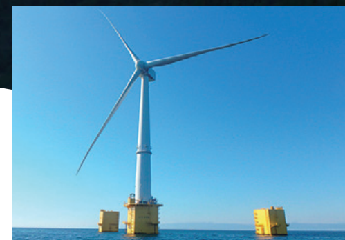
福島復興浮体式洋上ウィンドファーム実証研究事業 (出典：福島洋上風力コンソーシアム) 現在、福島沖で世界初の複数基による浮体式洋上風力発電システムの実証研究事業(経済産業省の委託事業)を展開。当社は、2013年に2MWの浮体式洋上風力発電設備を、福島沖20kmに設置。2015年には、2基目の風車となる7MWの浮体式洋上風力発電設備「ふくしま新風」(写真上)を設置
