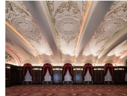
ホテルニューグランド本館 (新築施工、改修設計施工)
