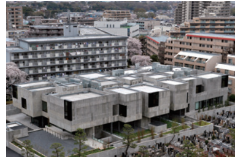
桐朋学園大学調布キャンパス1号館(施工)
