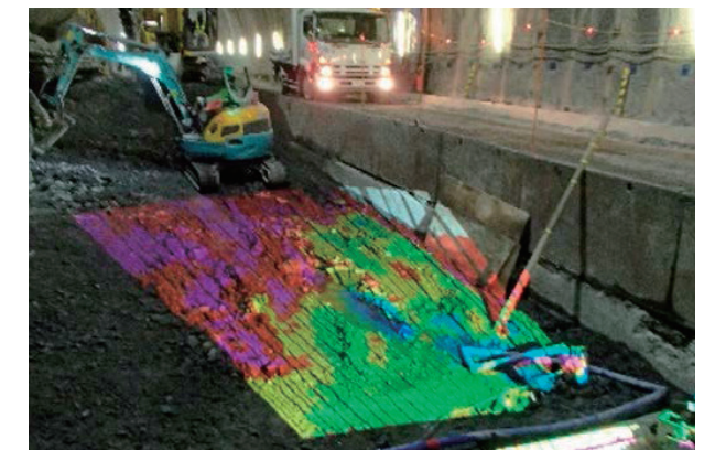
インパート底面に照射した画像データの様子
