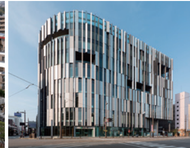
TOYAMAキラリ(施工)
