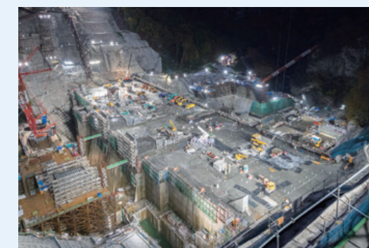
ICT技術を活用して工事が進むハツ場ダム
